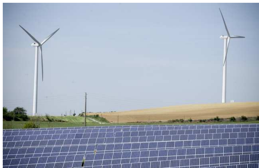
Fin du chantier d'un gigantesque parc photovoltaïque et d'un parc d'éoliennes. 5/05/2011 Avignonet-Lauragais - Frederic Scheiber/20MINUTES
